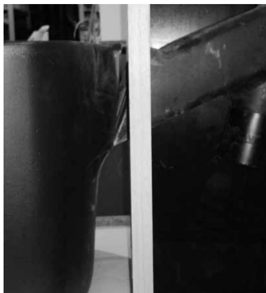
Изображение 1 Установите вентиляционный канал (компонент 7) через стену на своё место в корпусе туалета.
